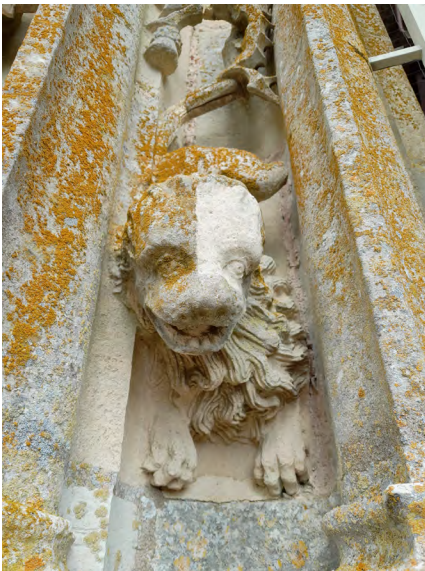
Tour nord, test de nettoyage sur une sculpture © DRAC Centre-Val de Loire, F.Audebrand.
