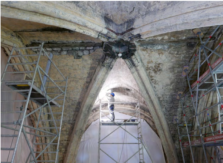
Voûte du transept en cours de restauration et d'étude © Archeodunum.
