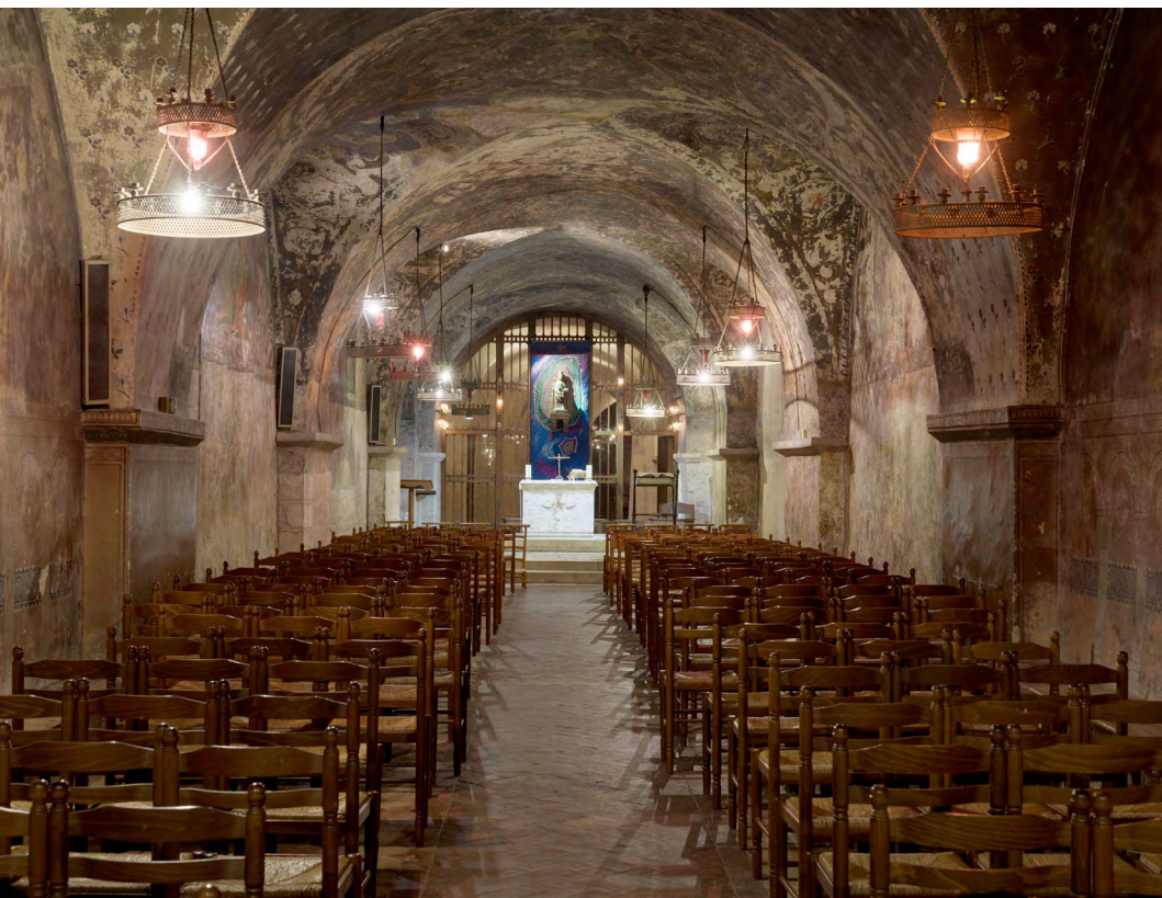
Vue du couloir sud de la crypte, en direction de la chapelle Notre-Dame de Sous-Terre © DRAC Centre-Val de Loire, F. Lauginie.
