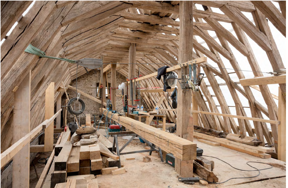
Charpente de la chapelle Saint-Piat en cours de restauration © DRAC Centre-Val de Loire, F. Lauginie.
